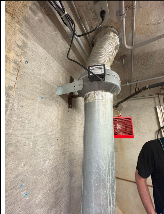
Figure 332: Ventilation Fan
